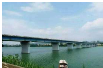
(b) 水上桥梁2 (b) Water bridge 2
