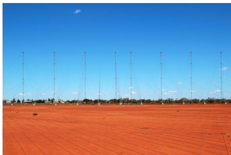
图 13 澳大利亚HILOW超视距雷达试验发射阵列 [81]
